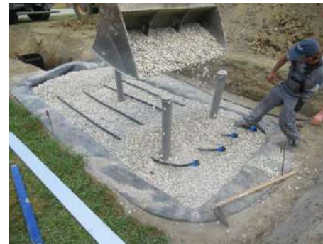
Polaganje dotočnih cevi na filtrni medij
