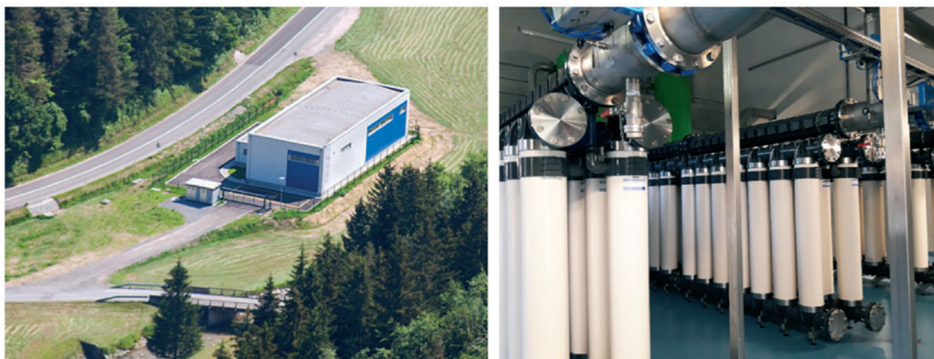
Slika 1: NPPV Čujež (levo) in ultrafiltracijske linije za pripravo pitne vode (desno).
